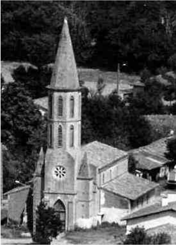
L'église de Marestaing avant les travaux de rénovation du clocher.
